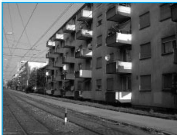
Schlechte Bausubstanz, ungenügende Schall- und Wärmedämmung.
