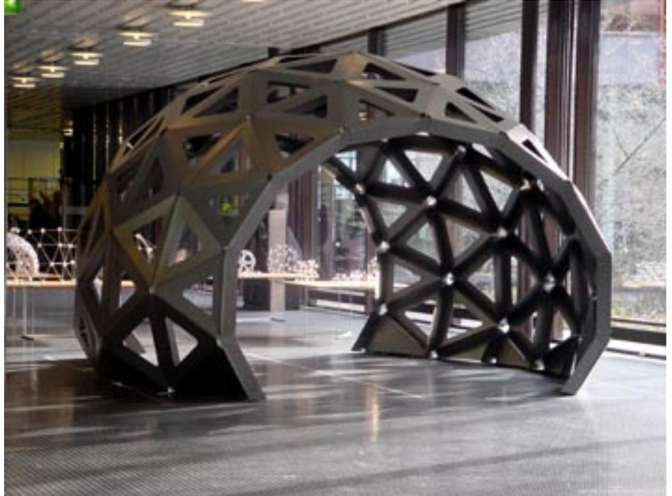
Innerhalb von nur sieben Tagen hat die Professur für CAAD in der Seminarwoche des Wintersemesters mit 11 Studenten einen Pavillon aus Stahlblech entworfen, programmiert und mit Laserschneidemaschine und Abkantpresse selbst gebaut. Der Pavillon ist das Produkt eines computerorientierten Entwurfs- und Produktionsprozesses.
