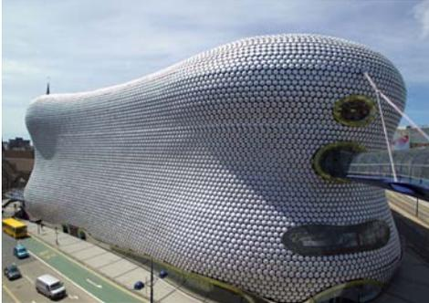
«**Konstruktiv** betrachtet besteht das viergeschoßige Gebäude aus einer Stahlrahmenkonstruktion mit Geschosßdecken in Stahlbetonbauweise, die sich ringförmig um das zentrale Atrium gruppieren. Die äußere Schale wird von einem mit Spritzbeton versehenem Stahl-Maschengitter gebildet. Sie verleiht dem Gebäude seine organische Struktur und dient als zusätzliches Aussteifungselement zwischen den einzelnen Geschoßebenen.
